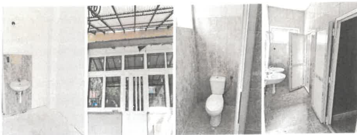
A Mályi üdülő belső burkolatának alakulása, valamint megújult bejárata
